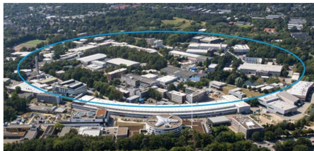
DESY-Campus in Hamburg mit dem 2,3 Kilometer langen PETRA III-Beschleunigerring (blau). Drei Experimentierhallen – im Vordergrund die bogenförmige Experimentierhalle „Max von Laue“ – sowie zahlreiche Labor-Gebäude von rund 20 interdisziplinären wissenschaftlichen Institutionen gruppieren sich um den Ring.
